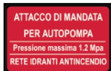
Gli **attacchi di mandata per autopompa** devono essere installati in modo da non provocare strozzature nelle tubazioni flessibili di adduzione, essere protetti da urti
